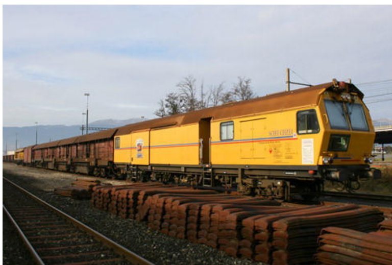
Train meuleur de rails (Scheuchzer S.A.)
