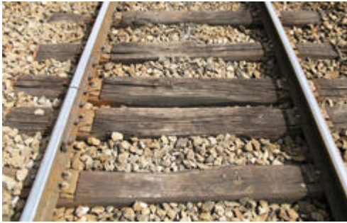
Rails courts sur traverses bois
